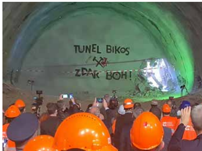
Obr. 8 Slávnostné prerazenie v kalote západnej tunelovej rúry
