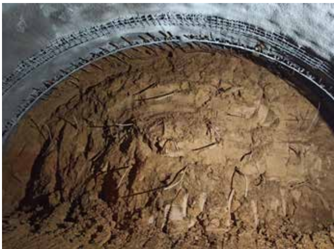
Obr. 7 Čelba v západnej tunelovej rúre – zvetrané plastické flovce
